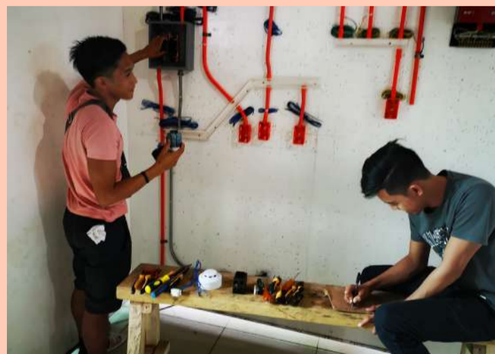
Dalawa sa mga nakapasang TESDA iskolar na sina Grayson Canales (kaliwa) at Mico Delos Reyes (kanan) habang aktwal na nagkukumpuni ng mga wirings sa kanilang teknikal na pagsasanay.
